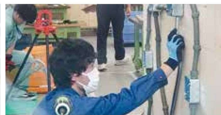
ものコン電気工事
